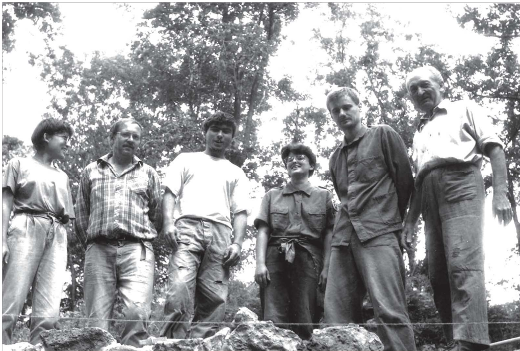
Členové kopřivnického kroužku při opravě portálu sklepních prostor
